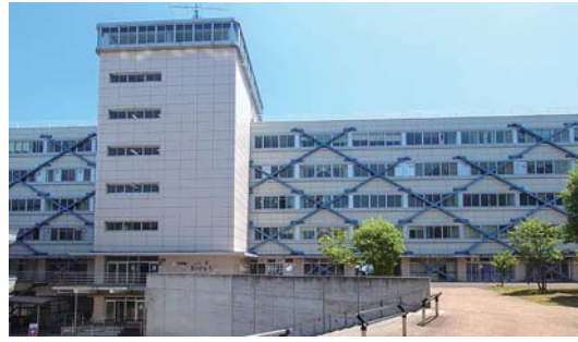
外付けブレースで補強した5号館
