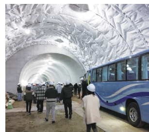
工事中のトンネル内部(普通の人が入ることが出来ない場所)に入ることが出来るというのも土木の醍醐味?)
