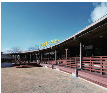
かさ上げ工事が完成した「道の駅もくもくランド」
