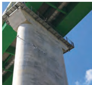
点検システム開発状況1(実地試験)
