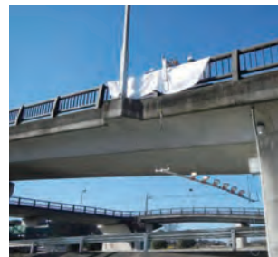
点検システム開発状況2(実地試験)
