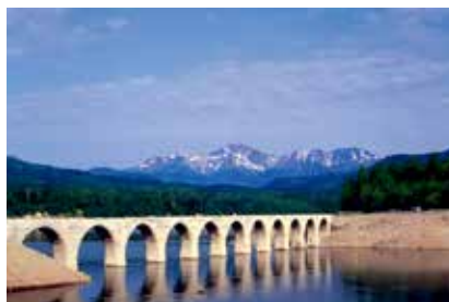
土木遺産（コンクリートアーチ橋）
