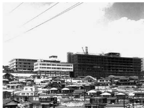
50年前の八木山と建設中の建築学科棟（5号館）
