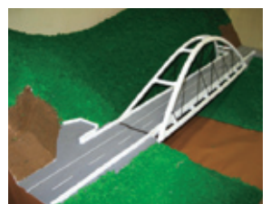
試作のニールセン橋
