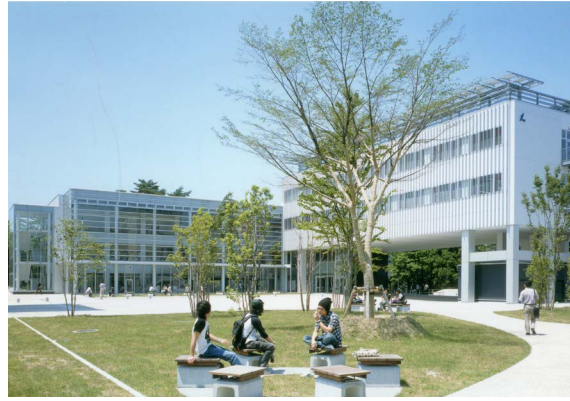
東北工業大学香澄町新1号館（施工に携わる）
